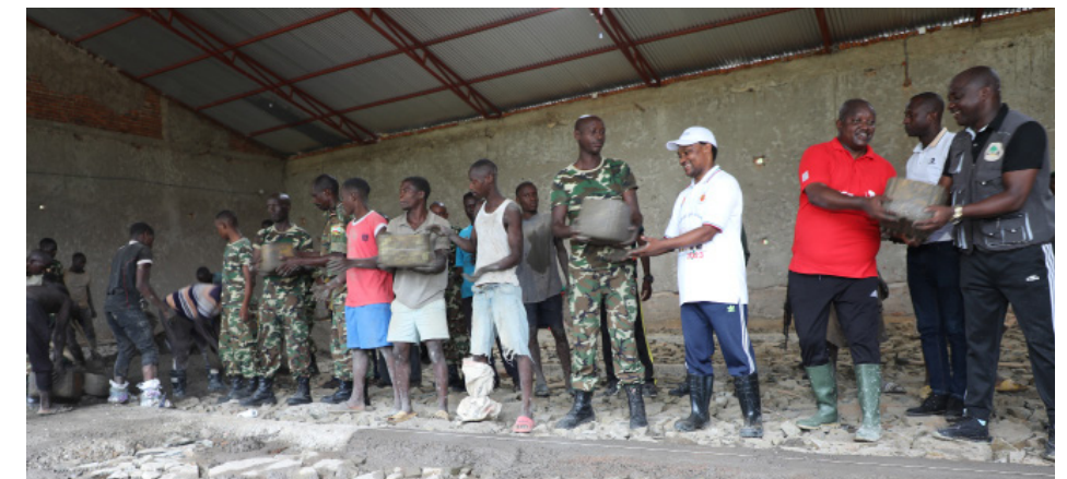
Des travaux de construction de la salle des réunions dans le camp de Rumonge avancent à grand pas
