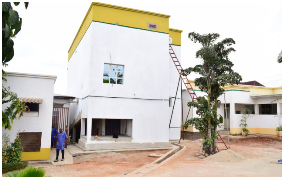
Un bloc de chirurgie-cardiologie en cours de construction
