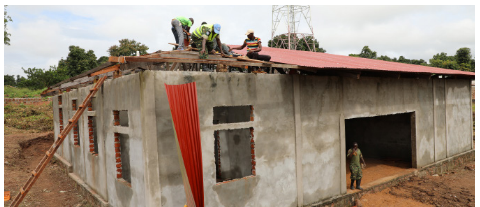
Les militaires burundais de la Minusca en collaboration avec population centrafricaine dans les travaux de réhabilitation du commissariat de la police à Dekoa
